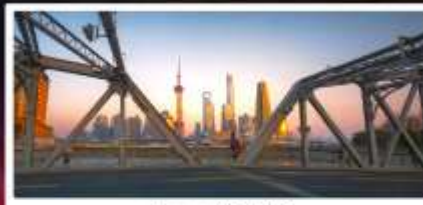
สะพานไวปี้ตู่
